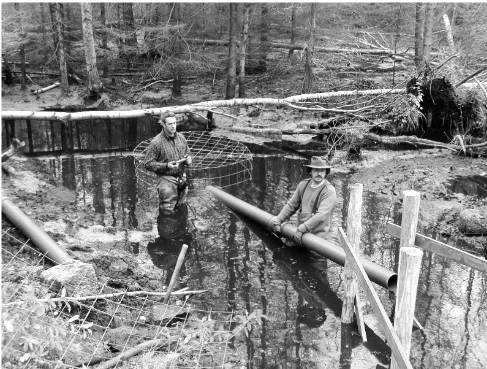
Ryc. 9. Montaż rury do kosza z siatki oraz ogrodzenia zabezpieczającego przepust kolejowy.
