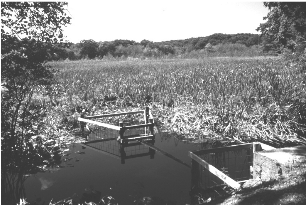
Ryc. 11. Ogrodzenie zabezpieczające przepust drogowy zostało połączone rurą (pod wodą, niewidoczna) z drugim ogrodzeniem. Bardzo skuteczne, estetyczne i długotrwałe zabezpieczenie.
