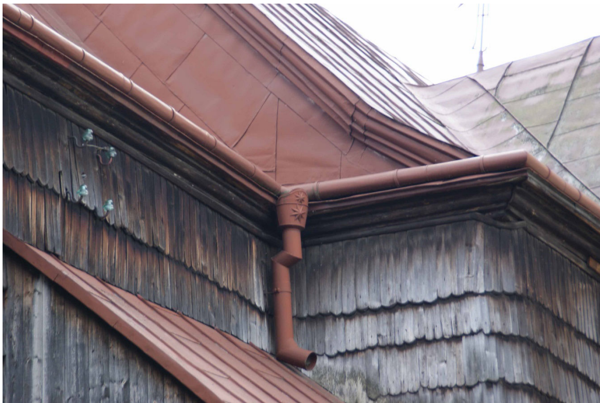
fot. 4. Kościół p.w. Św. Michała Archaniola w Ropie. Widoczne pokrycie dachu oraz pokrycie ścian wykonane z gontów.
