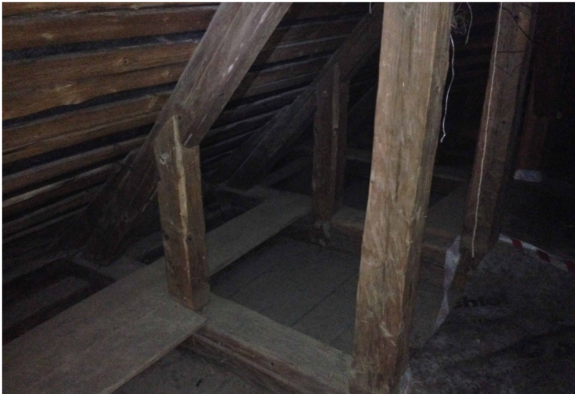
Fot. 10. Kościół p.w. Św. Michała Archaniola w Ropie. Widok na więźbę dachową i pokrycie z blachy.
