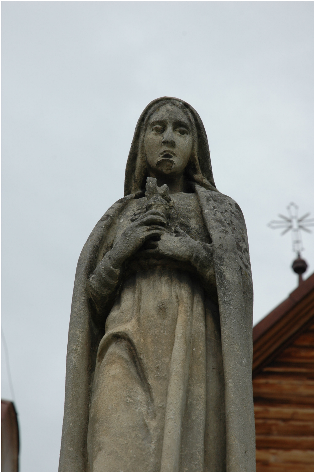
Fot.28. Kościół p.w. Św. Michała Archaniola w Ropie. Figura Matki Boskiej na słupie zachodnim bramy głównej ogrodzenia. Widoczny ubytek na twarzy.
