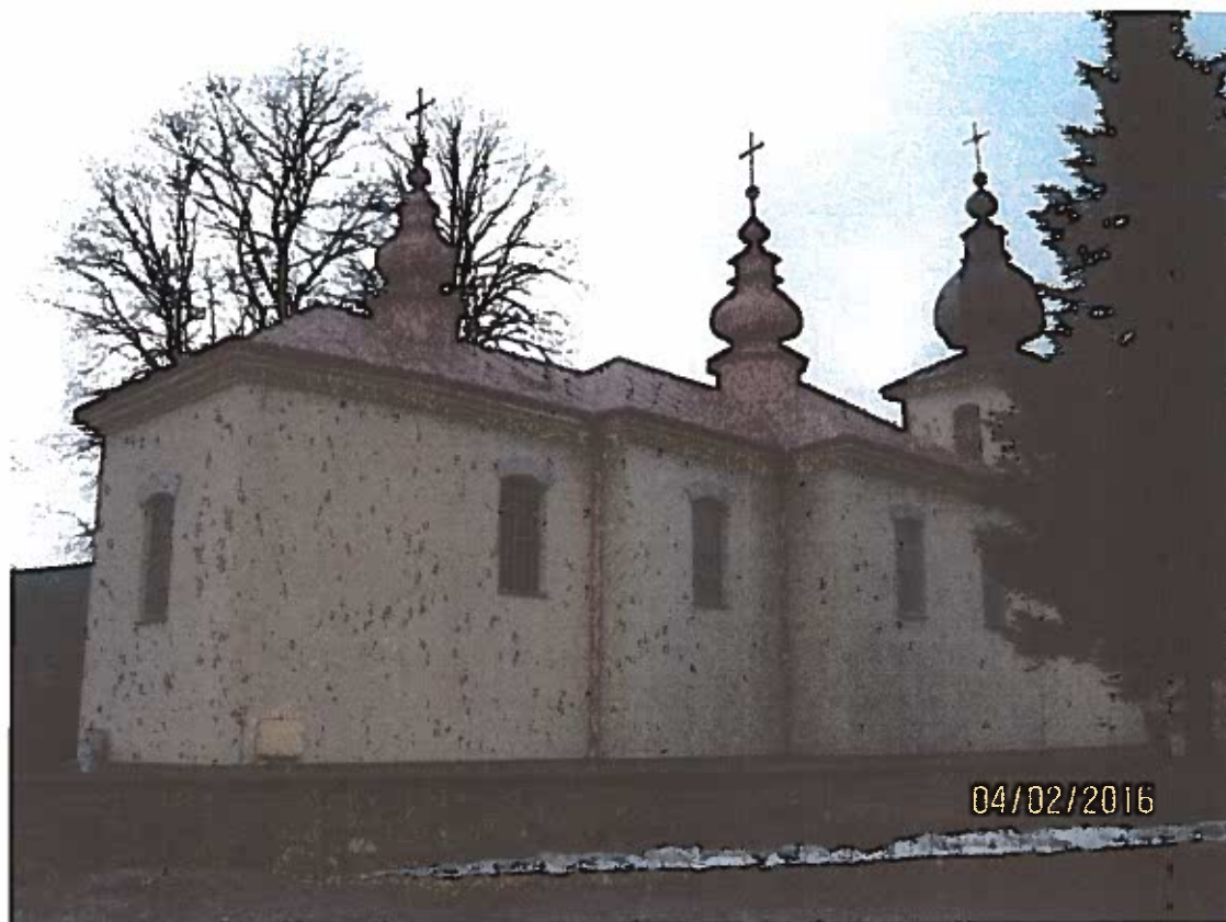
FOT. 1 – Budynek kościoła – widok od strony północnej. (fot. autor)
