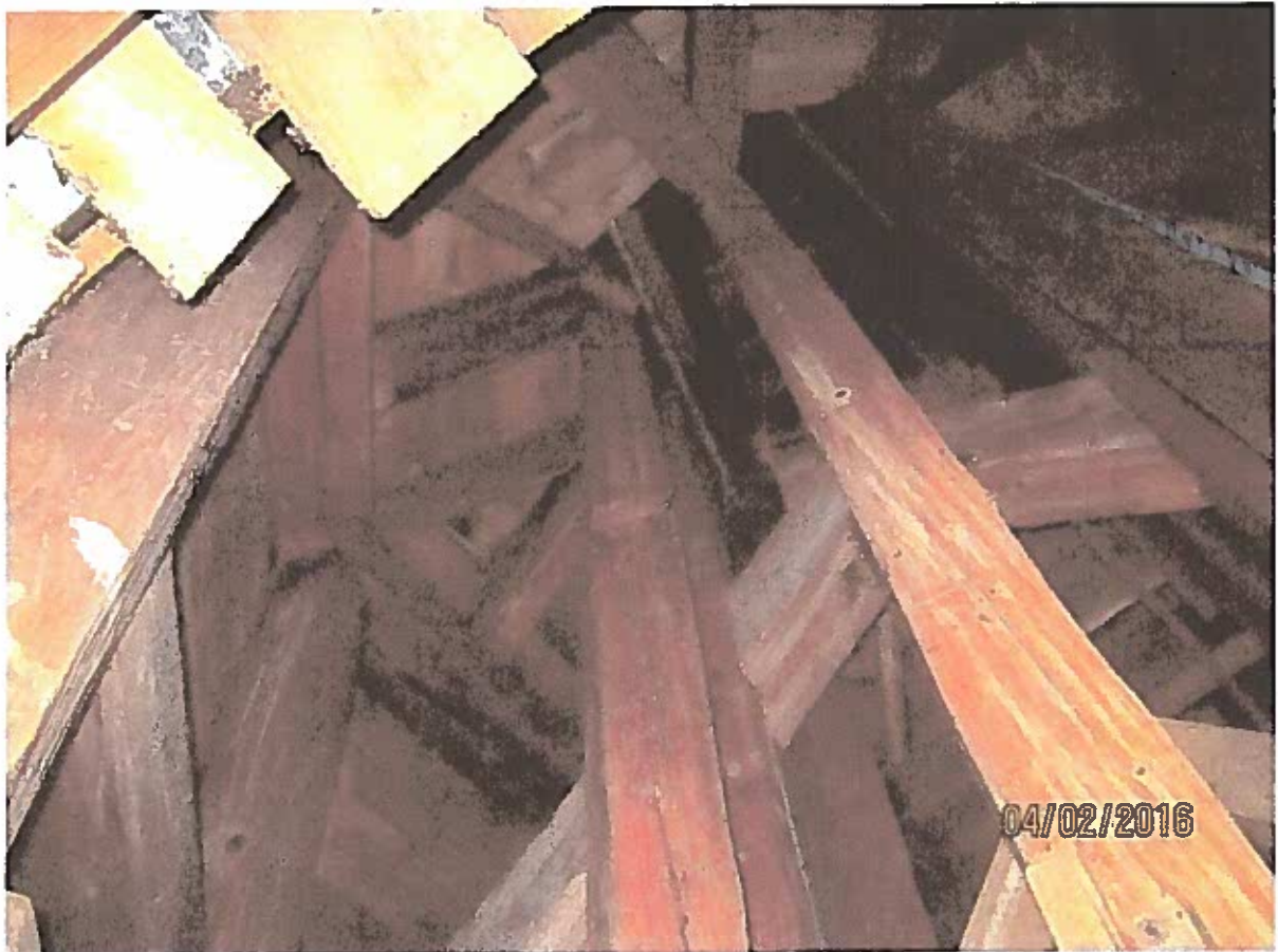
FOT. 3 – Drewniana konstrukcja sygnaturki. (fot. autor)
