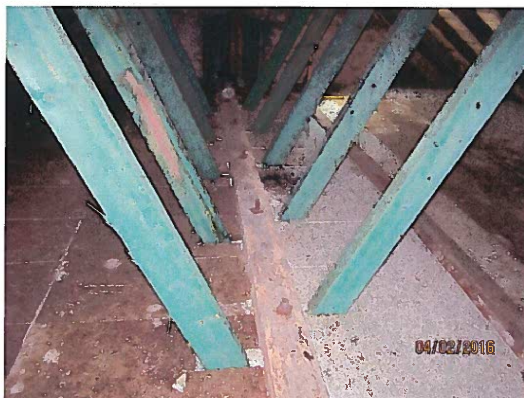
FOT. 6 – Poddasze budynku - widoczna belka podłużna ze śrubami w miejscu mocowania belek stropowych oraz belki wieszarowe podwieszające belki stropowe. (fot. autor)
