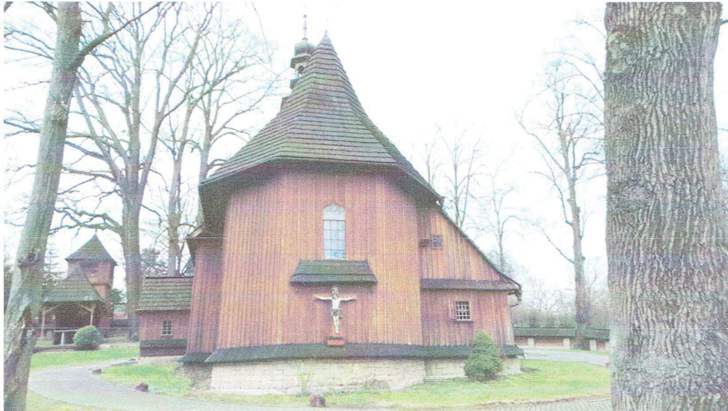
FOT. 3 – Budynek kościoła – widok od strony wschodniej. (fot. autor)
