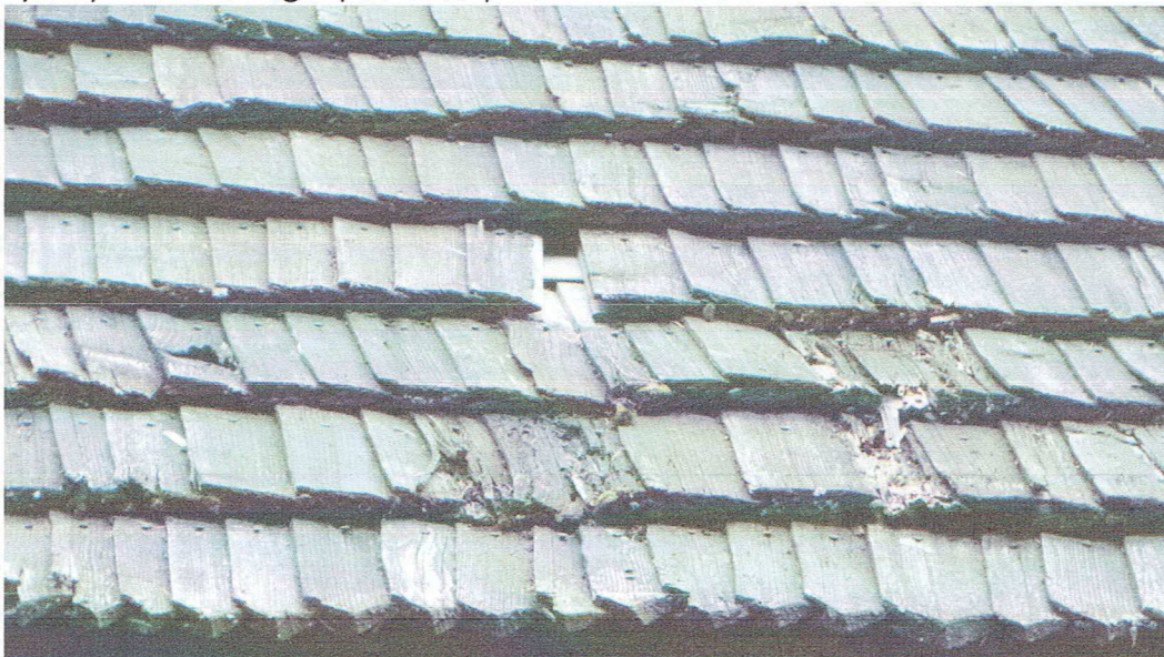
FOT. 7 – Fragment pokrycia dachu. (fot. autor)
