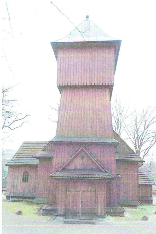
FOT. 1 – Budynek kościoła – widok od strony zachodniej. (fot. autor)
