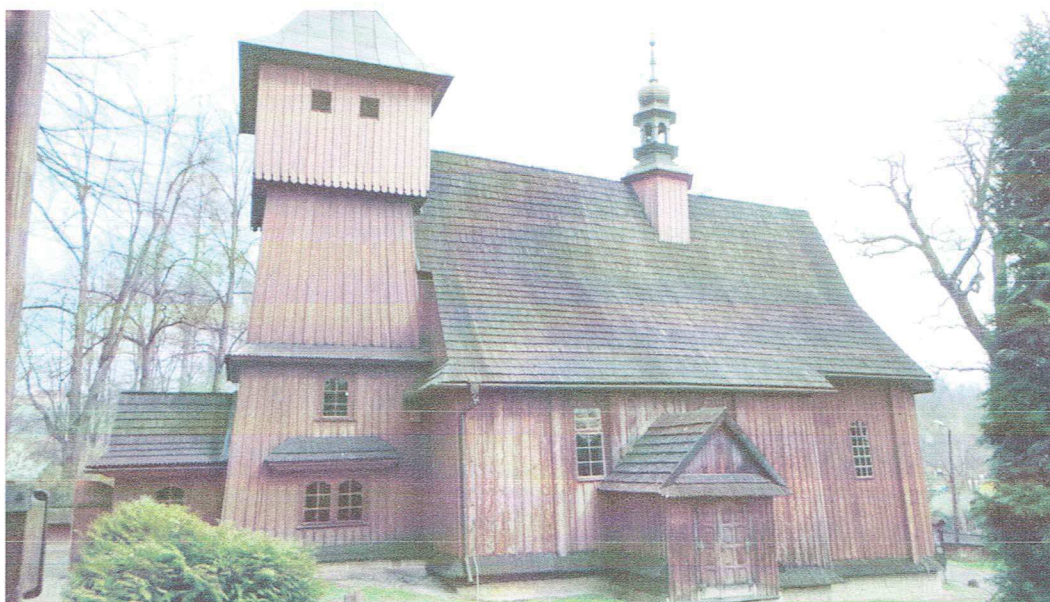
Fot.[2] Wygląd budynku od strony południowej. Fot. autor.
