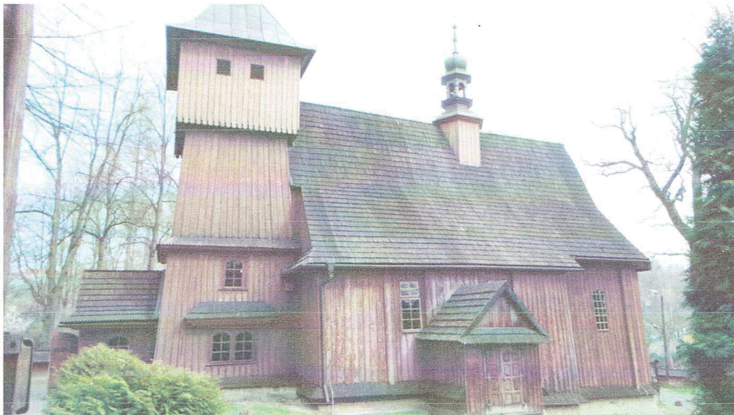
FOT. 4 – Budynek kościoła – widok od strony południowej. (fot. autor)
